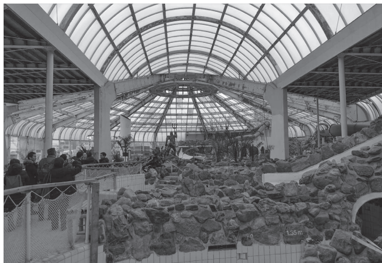
写真1 温水プールをリノベーションしたワークプレイス「ブルー・シティ」
