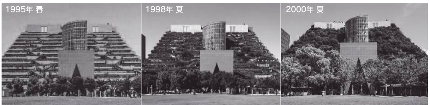
写真2 竣工からの経年変化。緑化したステップガーデンは天神中央公園と一体化し、都市の中に豊かな環境を創出している
