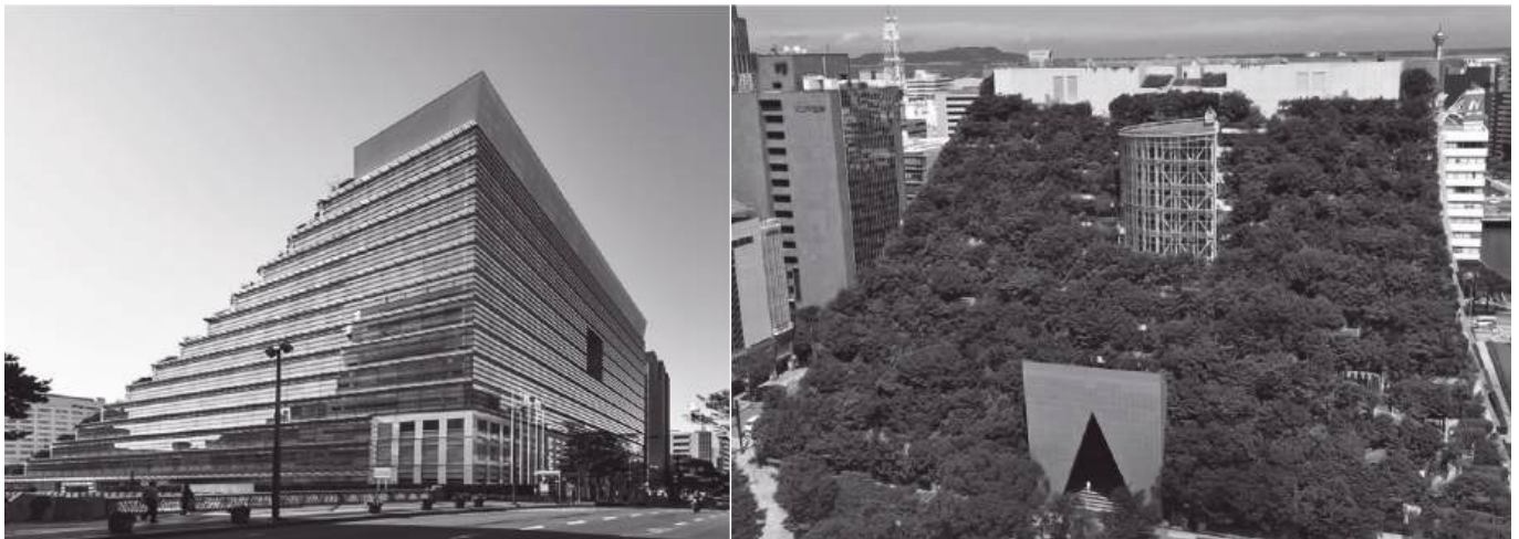
写真1 福岡県庁跡地に建設された公民複合施設「アクロス福岡」全景。北側（写真左）、南側（写真右）。天神中央公園に面した南側は、ステップ状の屋上庭園になっている
