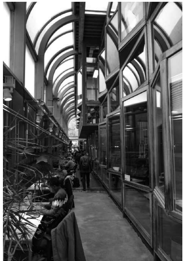
写真3 古い窓枠を再利用したジグザクの通路
