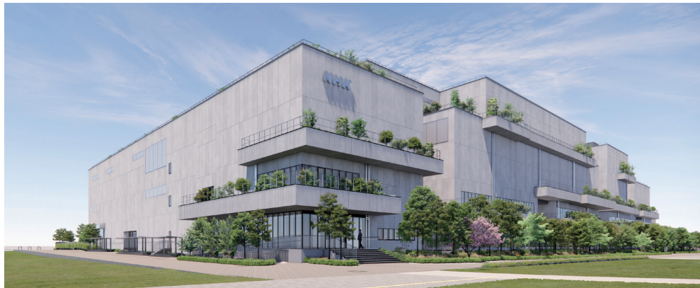
写真2 川口市に建設中のドラマスタジオ(完成パース)
