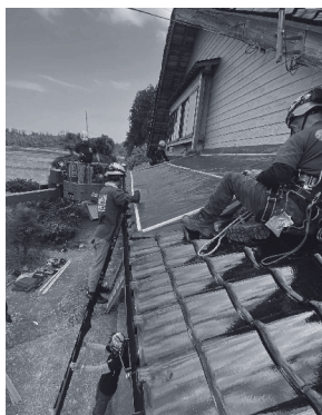
写真2 専門性が必要となる屋根上の作業は、技術系災害ボランティアが行う
