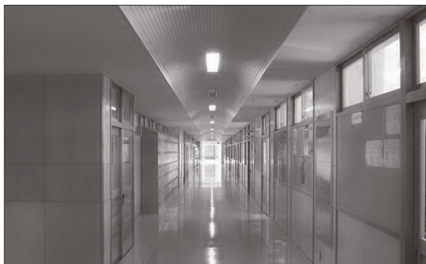
写真1 改修後の青森県立弘前工業高等学校管理教室棟内部
