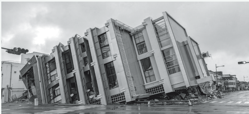
写真1 令和6年能登半島地震における輪島市の被害(著者撮影)
