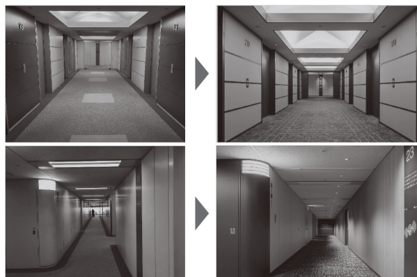
写真3 共用廊下改修
