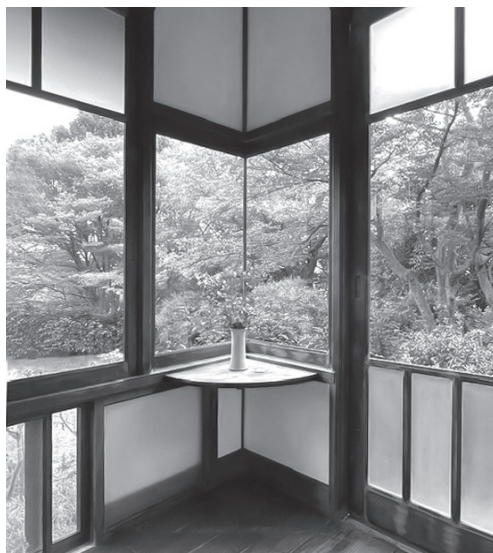
写真1 縁側のコーナー補強材を兼ねた棚
