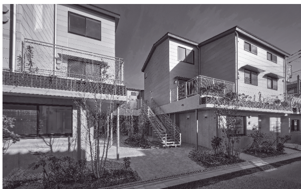
写真2 1階は鉄筋コンクリート造、2、3階はメゾネット型の木造住戸 写真/中村晃
