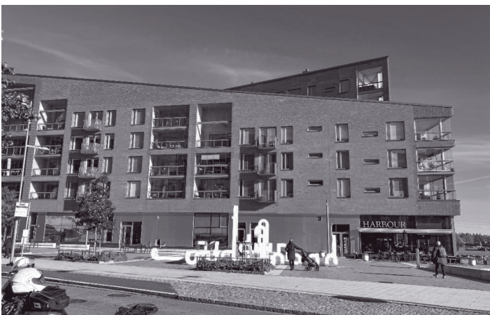
写真3 住戸は景観を活かしたエッジの効いたデザイン、アートも設置されている
