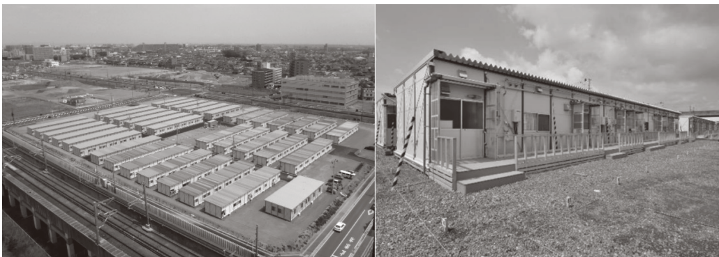
写真9、10 被災地への応急仮設住宅の供給
