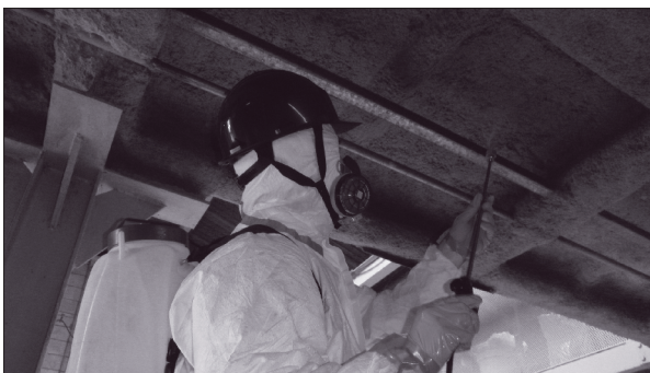
写真1 天井裏面でのアスベスト封じ込め処理の様子
