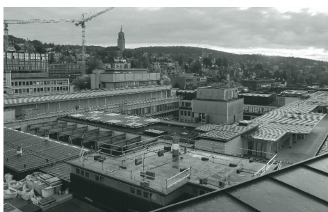
写真2 屋上から見た病院の施設群
