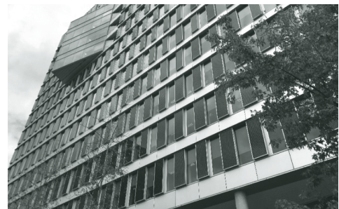
写真4 ディ・エッジ 太陽光パネルをサッシに組み込んだ南側のファサード
