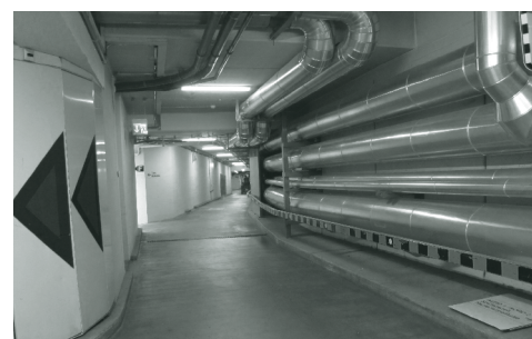
写真3 搬送業務を支える地下通路
