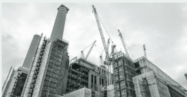
写真2 バタシー再開発(発電所の建物を残した開発)
