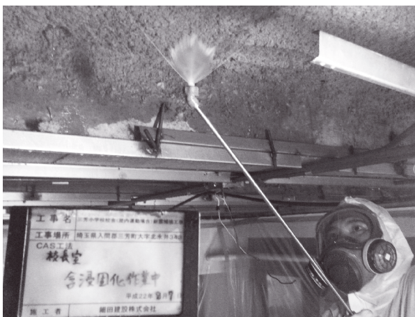
無害化封じ込め作業
