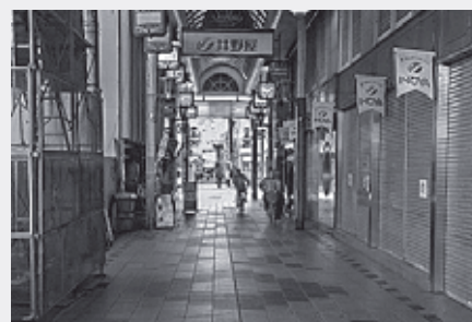
旧魚町サンロード商店街アーケード撤去前
