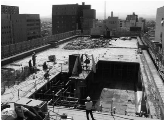
減築工事の状況
