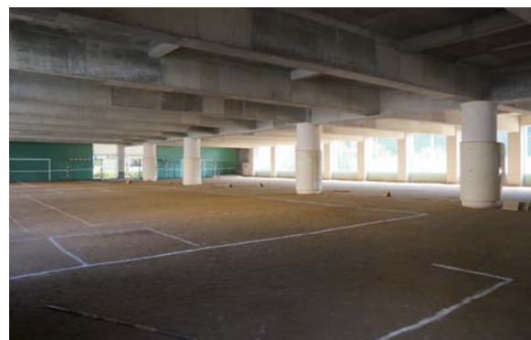
改修前 体育館 1F
