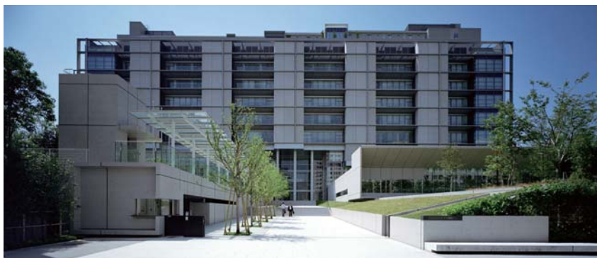
分散していた機能を集積した明治安田生命新東陽町ビル
