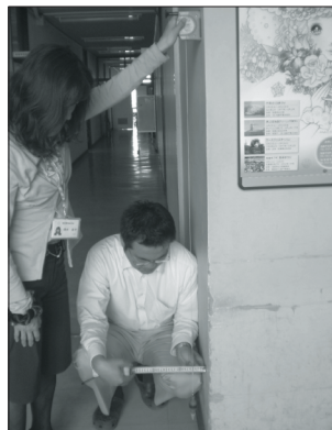
図2 庁舎の応急危険度判定
