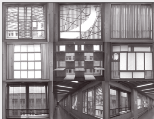
写真3 学内の廊下の窓に取り付けた建具
